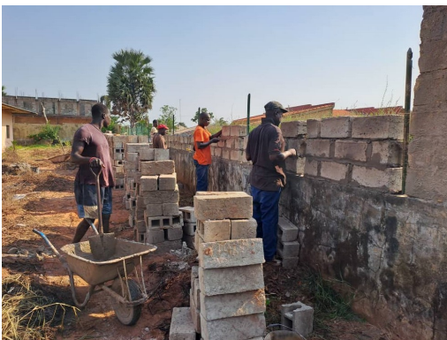
La costruzione a Canchungo
